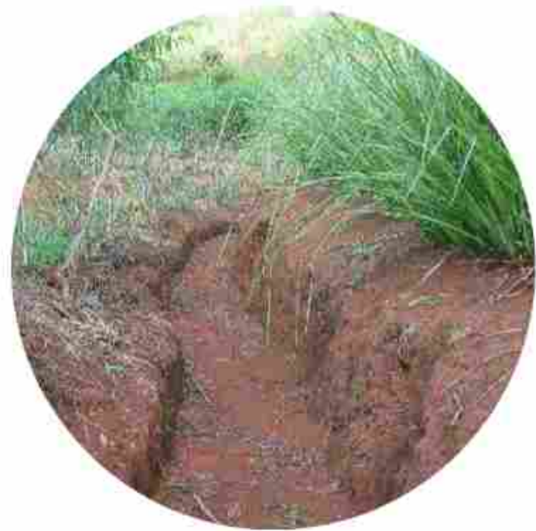
Canal de desviación de agua
